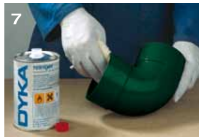
7 Binnenkant fitting reinigen
